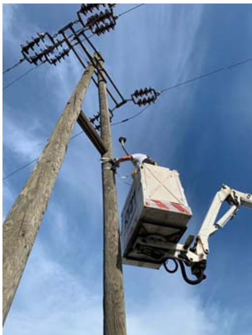
Slika 3: Montaža ALiSa-e na DV 35 kV Kleče – Vevče
